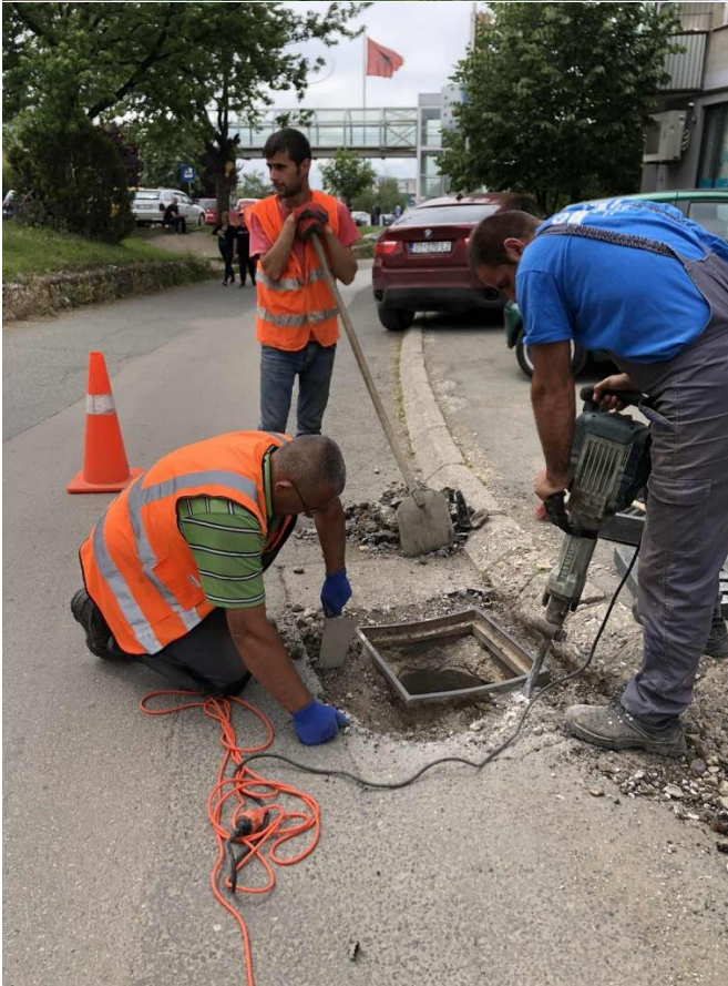
Mirëmbajtja dhe pastrimi i pusetave të ujërave atmosferike dhe shtratit të lumenjve
