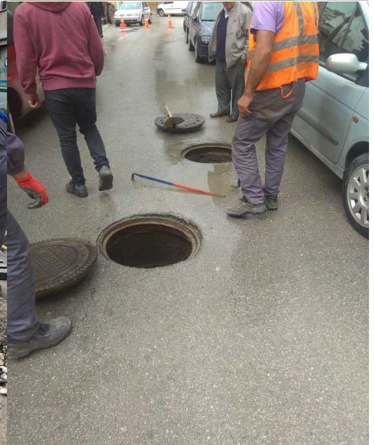
Mirëmbajtja dhe pastrimi i pusetave të ujërave atmosferike dhe shtratit të lumenjve
