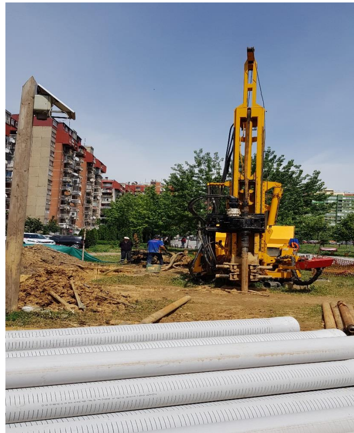
Shpimi i puseve dhe montimi i pompave për puse
