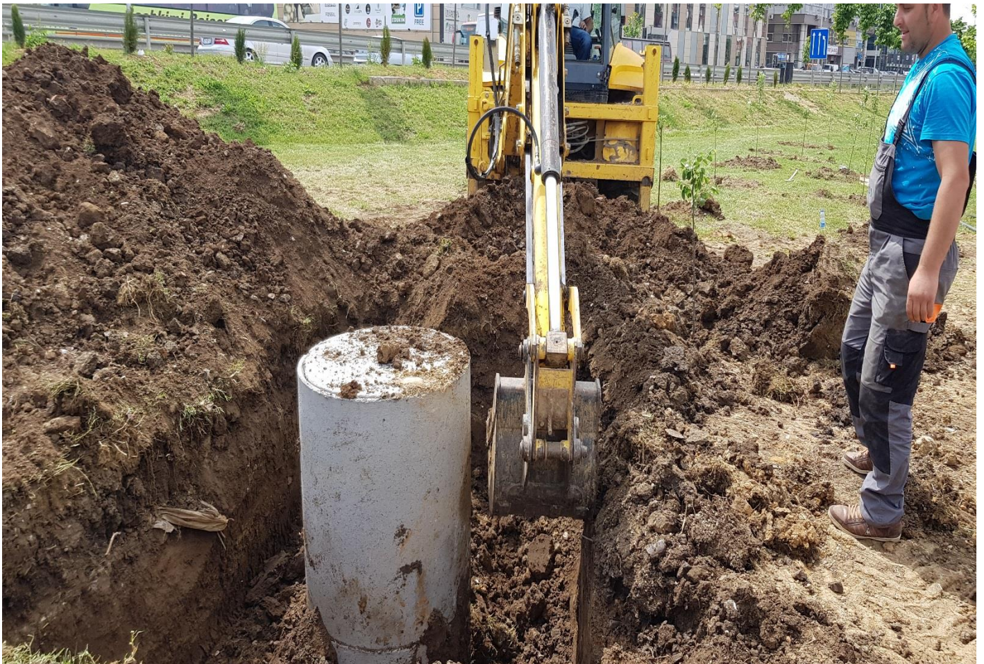
Shpimi i puseve dhe montimi i pompave për puse
