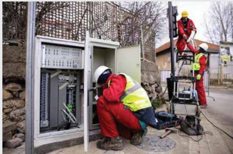
Instalimi i sistemit të tingëlloreve nëpër semaforë në rrugën e UQK-së
