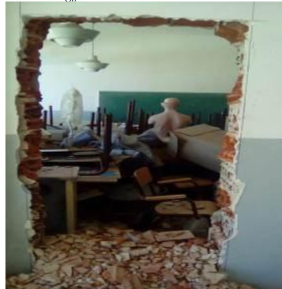
21.Ndarja e kaldatores te shkolla "Avni Rrustemi", Mramor, lagjja "Suteska"
