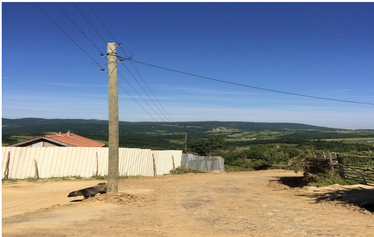
Pengesa e shtyllave elektrike, në mes të rrugës ,KEDS-i nuk po e bën zhvendosjen e tyre.
