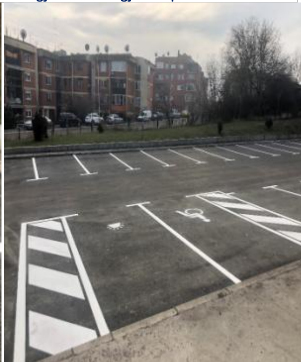
Asfaltimi i Parkingut tek Qendra e Mjekësisë Familjare në lagjen “Bregu i Diellit”
