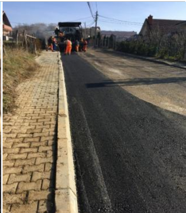
SANIMI I KANALIT NE RRUGËN QËNDRESA – MAT
