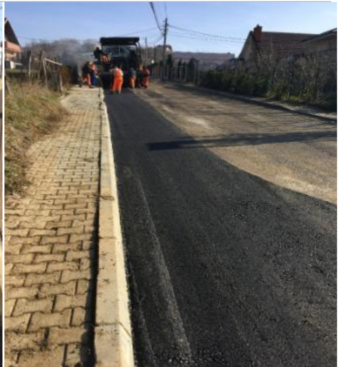
SANIMI I KANALIT NE RRUGËN "QËNDRESA", MAT
