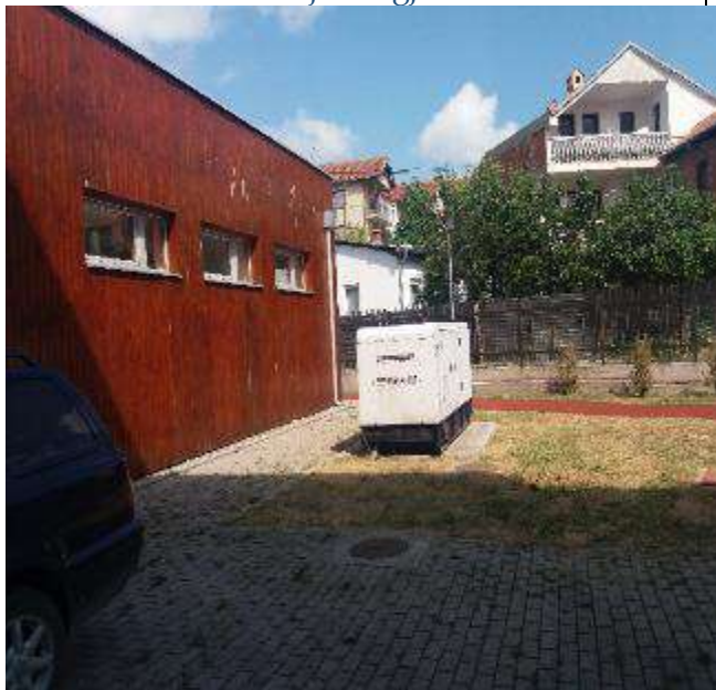
Bazamentet e vendosjes se gjeneratoreve
