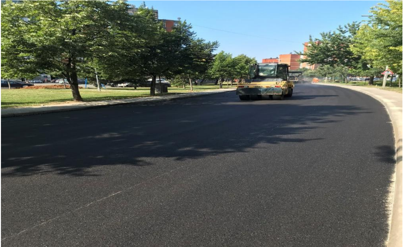
Asfaltimi i rrugës "Ilaz Kodra"
