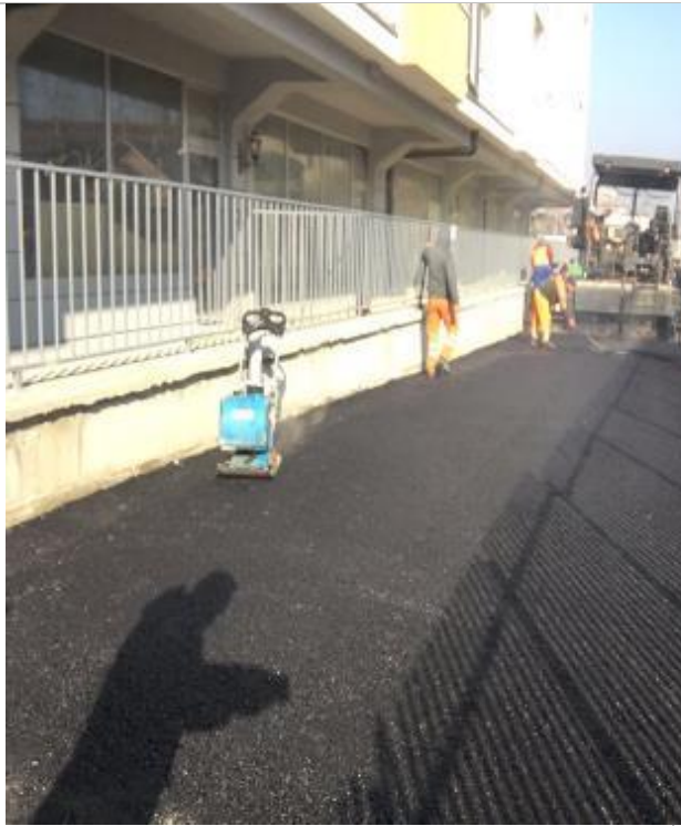
ASFALTIMI I RRUGES TE BANESAT E “TREGTISE”, AFËR RRUGËS “TIRANA”
