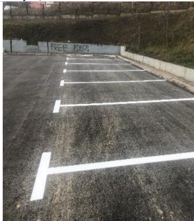
Asfaltimi i parkingut tek Qendra e Mjekësisë Familjare, në l. "Bregun e Diellit"
