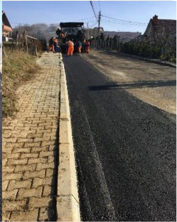
SANIMI I KANALIT NE RRUGËN “QËNDRESA” – MAT
