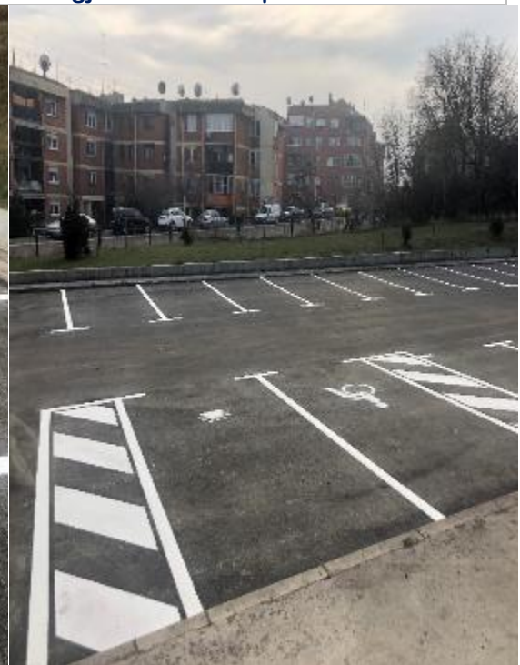
Asfaltimi i parkingut tek Qendra e Mjekësisë Familjare, në l. "Bregu i Diellit"
