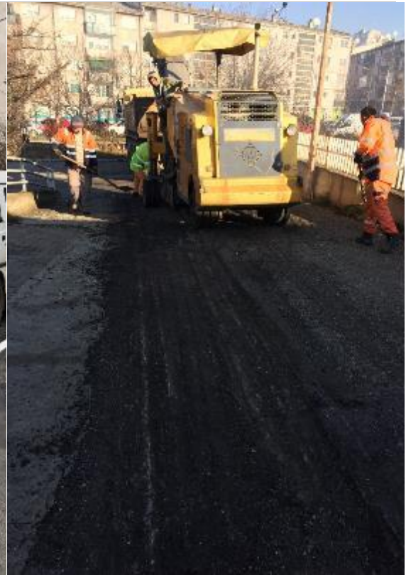
Asfaltimi i parkingut tek Objekti i Emergjencës në l. "Ulpiana"
