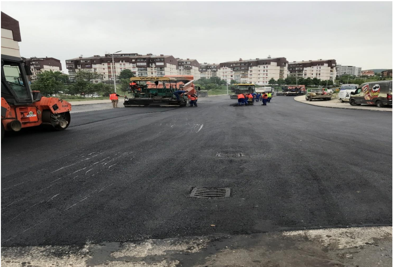
RIASFALTIMI I RRUGËS "XHELADIN HANA"
