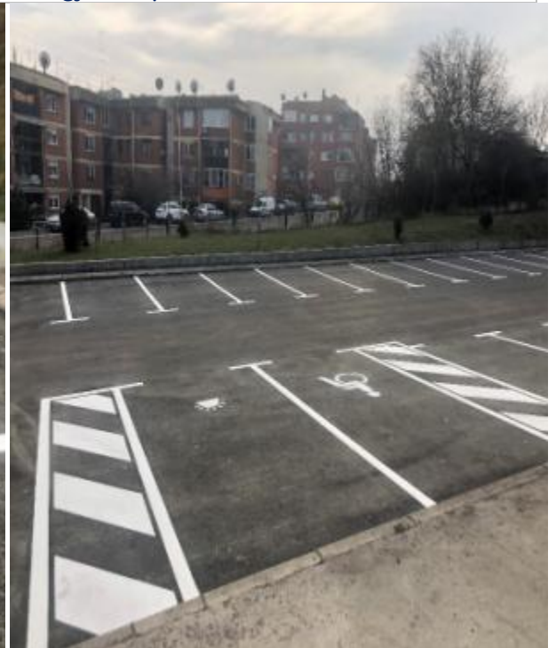
Asfaltimi i parkingut te Qendra e Mjekësisë Familjare në lagjen “Bregu i Diellit”
