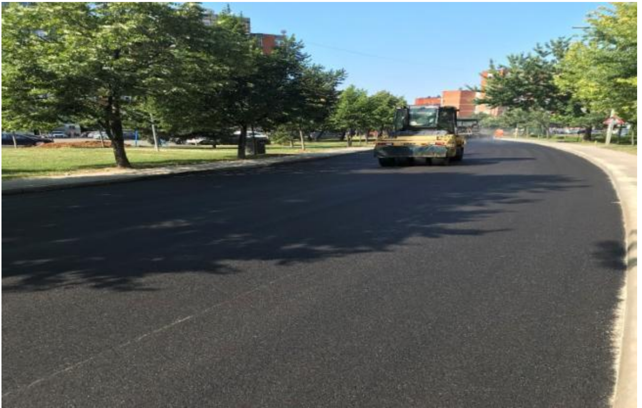
Asfaltimi I rrugës "Ilaz Kodra"
