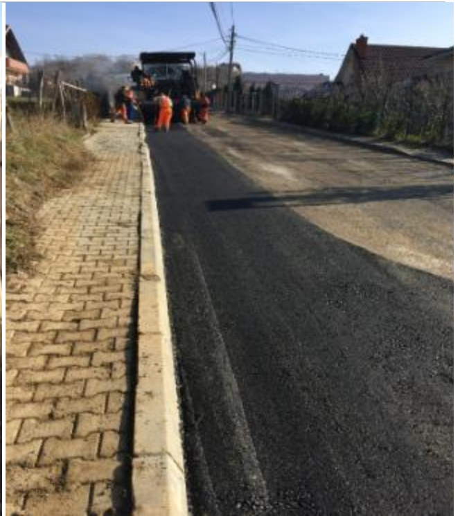
SANIMI I KANALIT NE RRUGËN "QËNDRESA" – MAT
