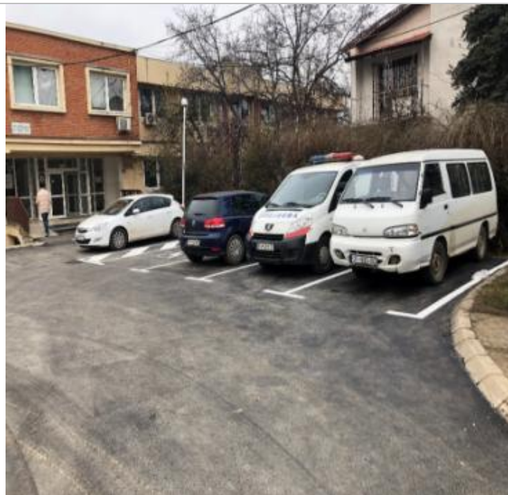
Asfaltimi i parkingut tek Qendra e Mjekësisë Familjare në lagjen “Dardania”
