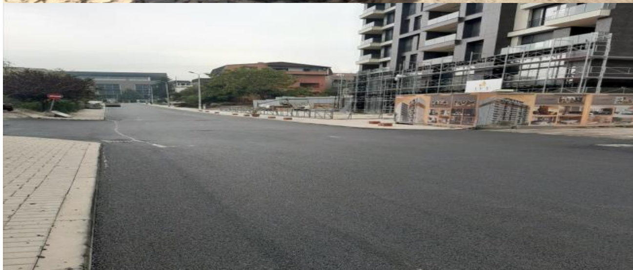
Asfaltimi i rrugëve "Karl Gega", "Ali Pashë Tepelena" dhe "Gazmend Zajmi"
