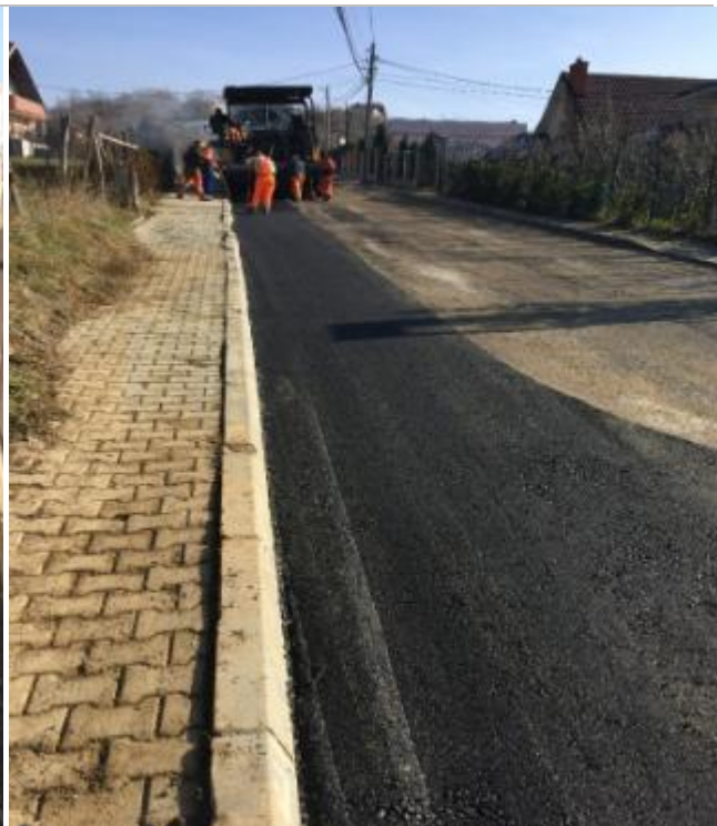
SANIMI I KANALIT NE RRUGËN "QËNDRESA", MAT
