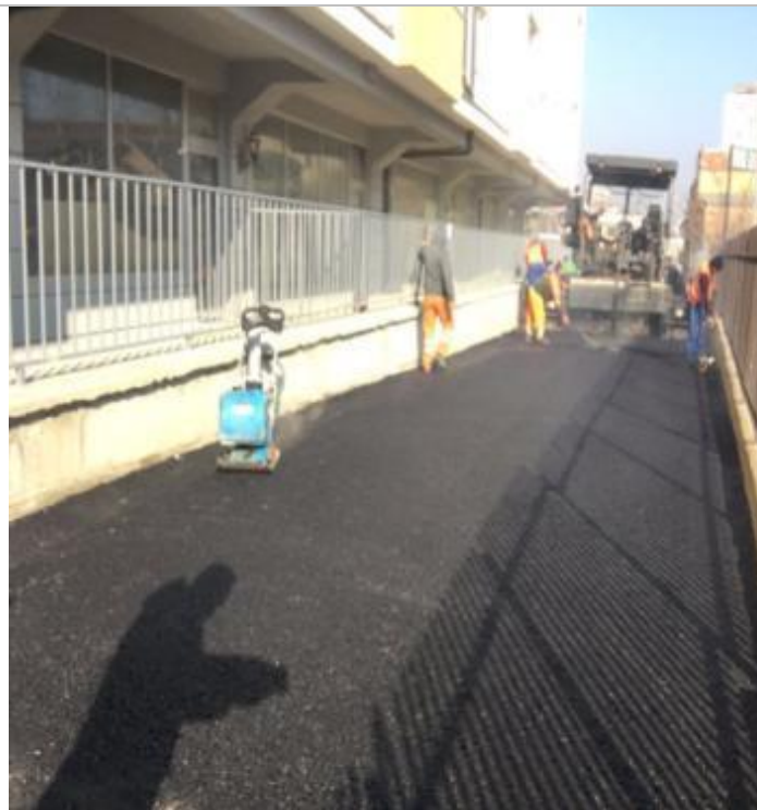
ASFALTIMI I RRUGES TE BANESAT E TREGTISE, AFER RRUGES "TIRANA"
