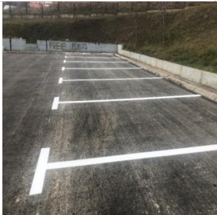
Asfaltimi i parkingut tek Qendra e Mjekësisë Familjare në lagjen “Bregu i Diellit”
