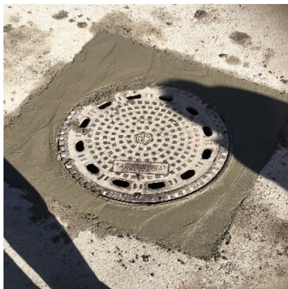
Pastrimi dhe rregullimi i kanalizimit atmosferik nga puseta në puset".
