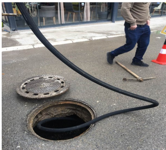
Pastrimi dhe rregullimi i kanalizimit atmosferik nga puseta në puset".
