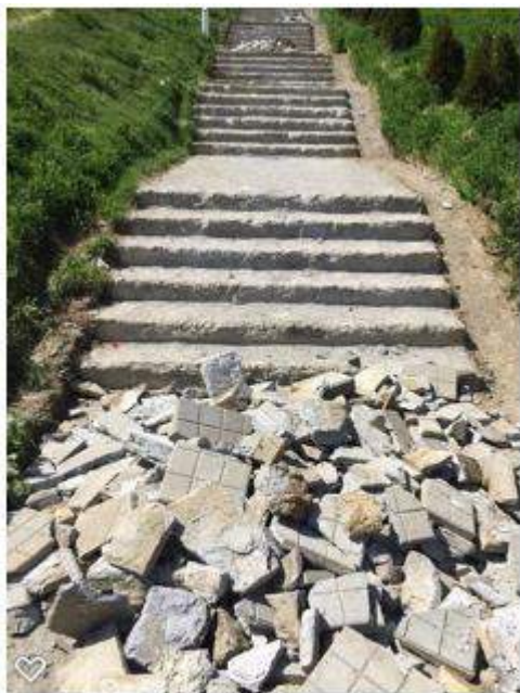
Demolimi i shkalleve
